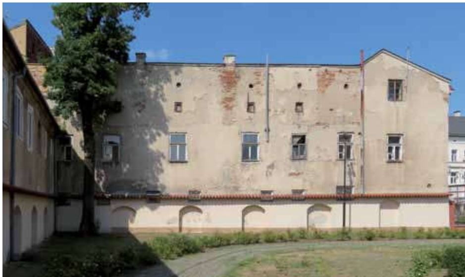
Oficyna kamienicy z ul. Żeromskiego 4 od strony cmentarza przy kościele oo. Bernardynów. Najbardziej prawdopodobne miejsce narodzin Wandy Malczewskiej. Fot. Paweł Puton, 2019
